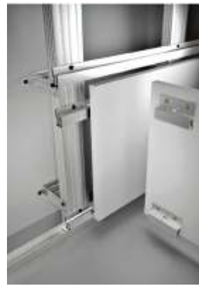
Zavesenie panelov na profily a plechové profily
