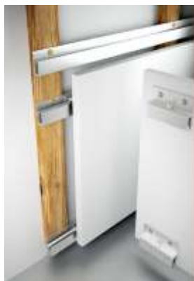
Zavesenie panelov na profily a drevené hranoly
